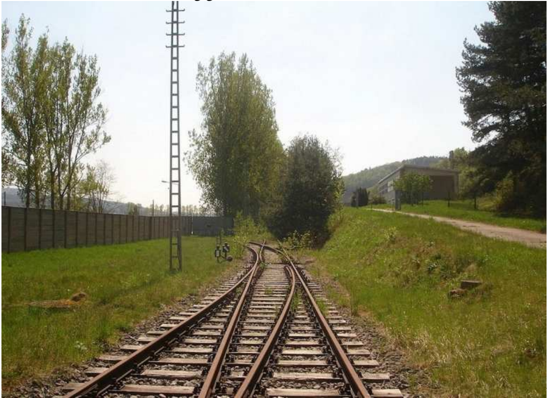
Im Rothensteiner Bunker können ganze Züge verschwinden. Schienen sind bereits vorhanden.
