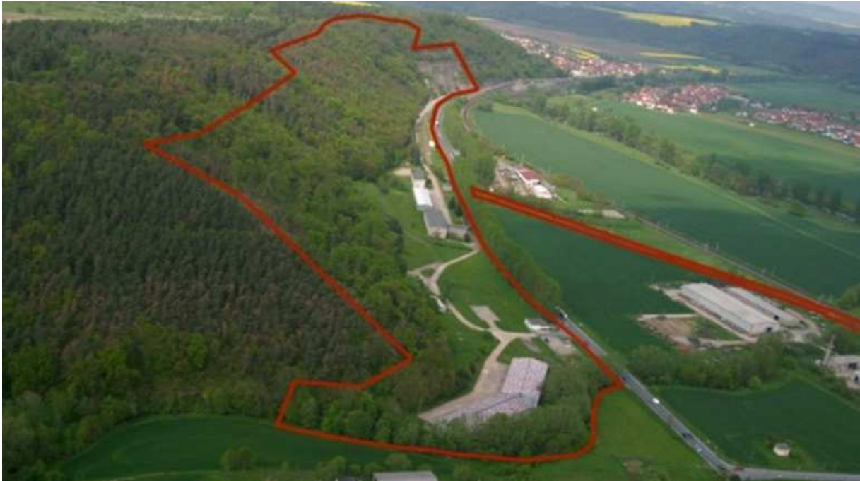
Das zusammenhängende Tunnelnetzwerk ist insgesamt fünf Kilometer lang. Das System enthält zwei Belüftungsanlagen sowie eine eigenständige Wasser- und Stromversorgung und ist damit vollkommen unabhängig von der Außenwelt.
