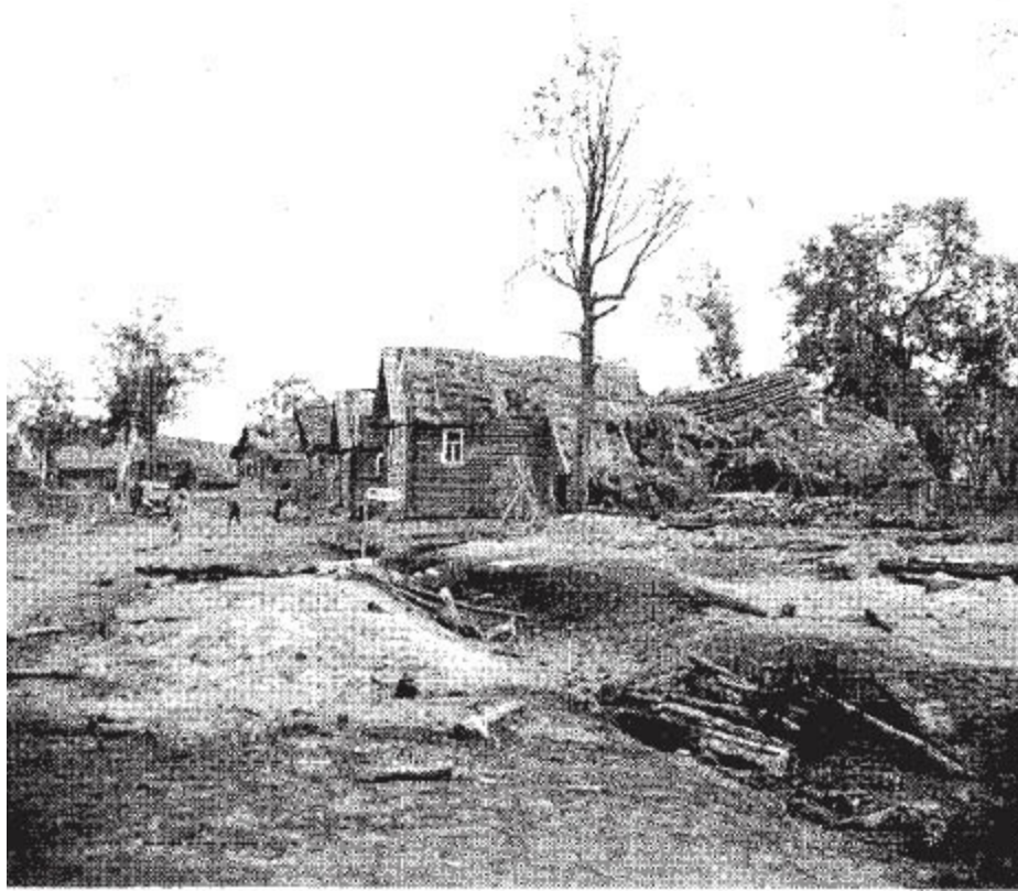
Eine Ansiedlung direkt hinter der alten russischen Reichsgrenze.
